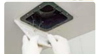
3 カバーを開け、留め金をはずしてカバーをはずします。
