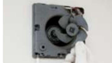
6 換気扇の羽根を留めているネジをスパナかペンチでゆるめ、ネジ、羽根をはずします。
