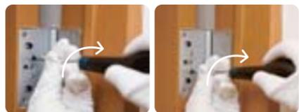
2つある「左右調整ネジ」のうち最初に上のネジを調整します。プラスドライバーで少し右に回転させます。次に下のネジも同じように調整しドアの傾きを直します。
