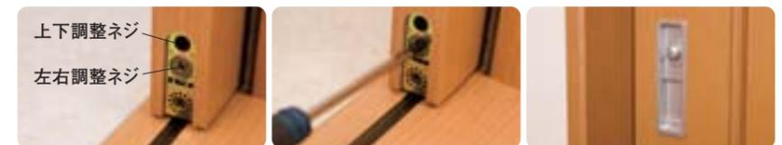
プラスドライバーで「上下調整ネジ」を左に回し、引き戸の高さを上げます。少しずつ回すのがポイントです。その都度引き戸の閉まり具合を確認。ロックが「カチッ」とかかるようになるまで繰り返してください。
