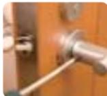
ネジを締め、取っ手がガタガタなくなったら調整完了です。
