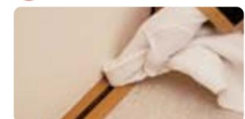
シリコンスプレーを雑巾に吹き付け、レールの溝をきれいに拭きます。ドアの反対側のレールも同じようにお手入れします。
