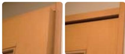
「左右固定ネジ」をしっかり締め付け、固定します。調整の都度ドアの閉まり具合を確認。ドアが当たったり、こすれたりしなくなるまで確認しながら①～③を繰り返します。
