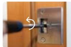
ストライクの中心部分にあるネジをプラスドライバーで回して調整します。ドアをびったりと閉めたい場合は、金具を左に動かします。ネジを右に回すと金具が左に動きます。
