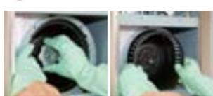
ファンを押さえ、ツマミを「ゆるむ」の方向に回してはざした後、ファンを取り出します。
