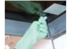
上面両角の突起部(ネジ)をゆるめて整流パネルを開きます。
