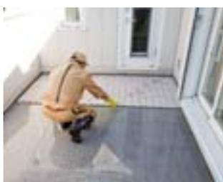
防水シートの掃除が終わったらタイルシートを元の位置に戻し、排水口側の残りの1/4スペースも④と同じ手順で掃除します。
