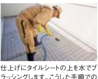
仕上げにタイルシートの上を水でブラッシングします。こうした手順でのベランダのそうじを年1~2回すると、見た目の美しさだけでなく状態の良さも長持ちします。
