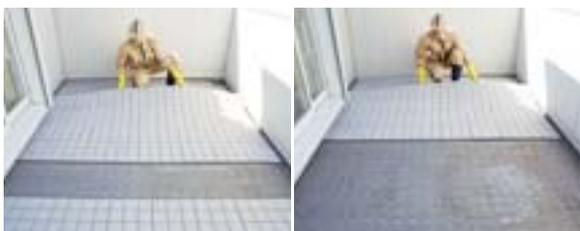
外したタイルシートは、排水口のある方へ順番に重ねます。ベランダは排水口側へゆるやかに傾斜しているので、こうすることでそうじ中の汚水の流れがスムーズになります。
