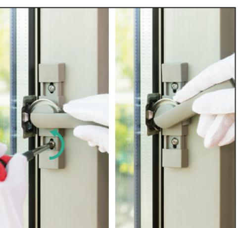
③ 調整が終わったら、プラスドライバーで上下2ヶ所の取り付けネジを右(時計回り)にまわして締め、上下のキャップを閉めます。
