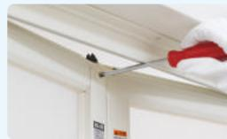
脱衣室側に付いている調整ネジをドライバーでゆるめ、ラッチの出ている長さを調整します。上げればきつくなり、下げればゆるくなります。
