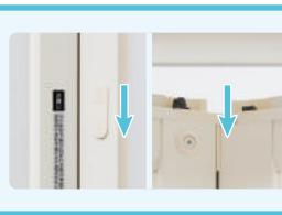
ツマミを上げればロックされ、下げれば解除されます。また、浴室側からロックされ開かない場合にもツマミを下げることでロックが解除されます。
